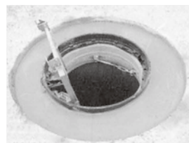
5 路盤材充填作業 ラウンドベースを用いて路盤部を充填します。
