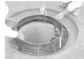
4 受枠設置作業 受け枠を設置し、路面の高さに合わせてレベルを調整します。
