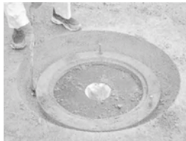
3 土砂除去作業 切断完了後、ブレーカー等を用いてマンホール周辺の土砂を除去します。
