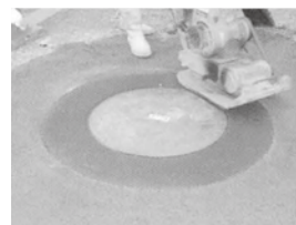
6 表層材充填作業 ラウンドベース硬化後、固まる君を敷き均し転圧します。
