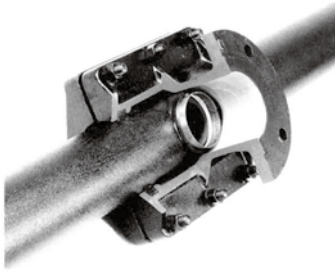
SUSブッシュ取付状況 (管外面)
